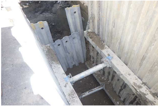
埋戻し前、上流端部に土留を設置
