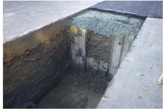
次スパンの床堀時、下流側の土留として機能
