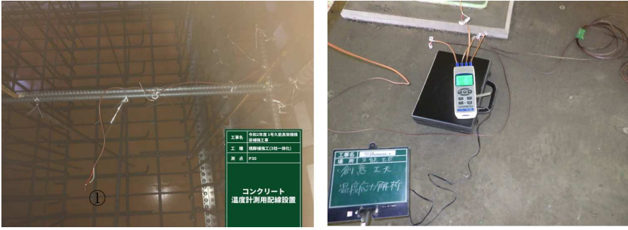
写真 コンクリート養生温度計レコーダの設置
