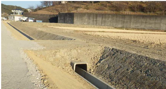
施工例：追加乗入工の設置
