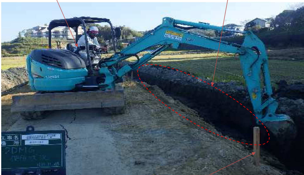
掘削高と位置を示す最小限の丁張り
