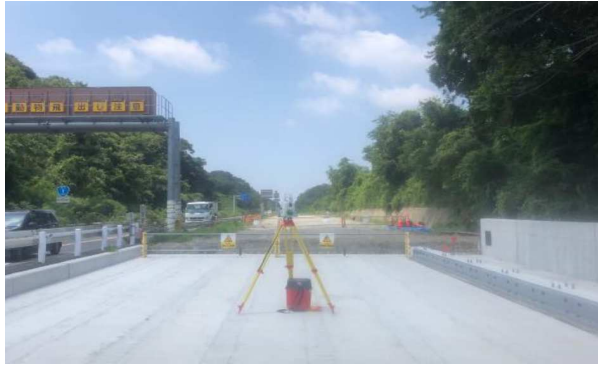
TLSによる測量状況
