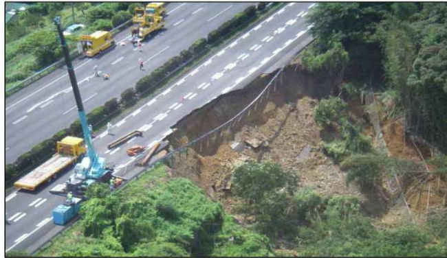
図-4-II-1 東名牧之原SA付近の盛土崩落状況
