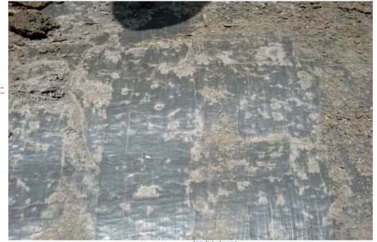
No.237+10 掘削底面
