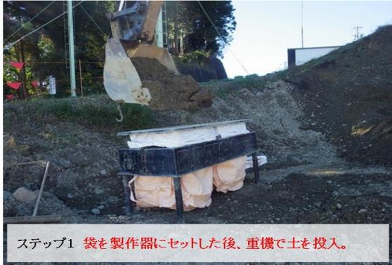
ステップ1 袋を製作器にセットした後、重機で土を投入。
