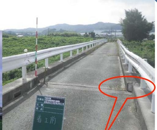
橋脚破損による床版のズレ
