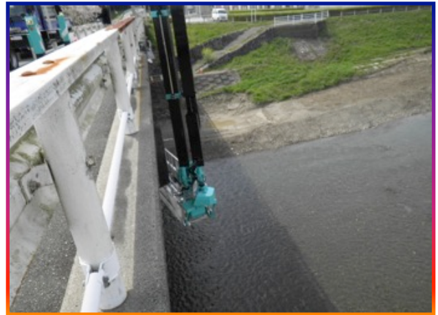
②落橋防止システム工(PCケーブル)
