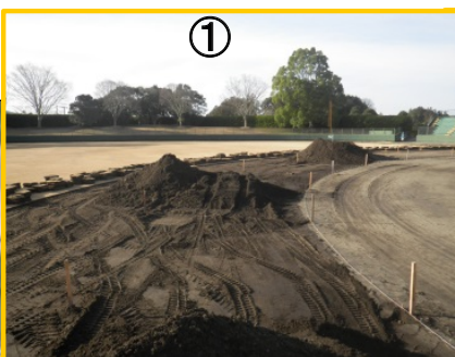
① 外野芝生撤去・切り下げ工
