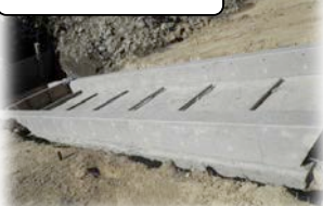
階段施工状況
