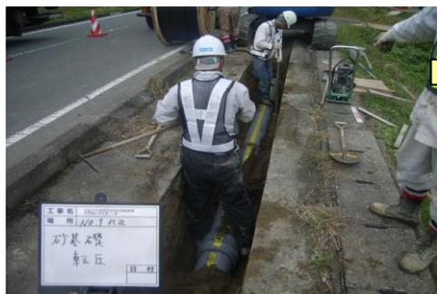
管を所定の位置、深さに布設できたら、管の周りに砂を敷き詰め保護します。
