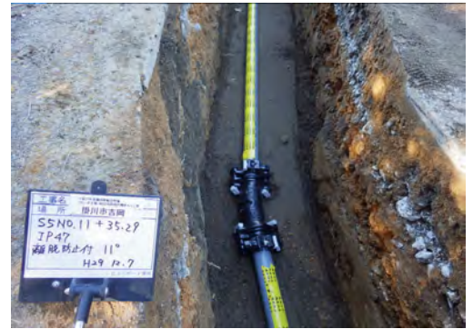
写真 農業用水管の敷設
