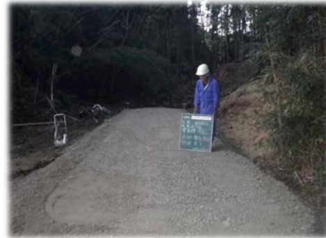
仮設排水管埋戻し完了
