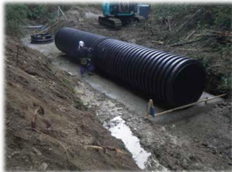
仮設排水管据付状況
