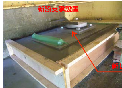
コンクリート打設
