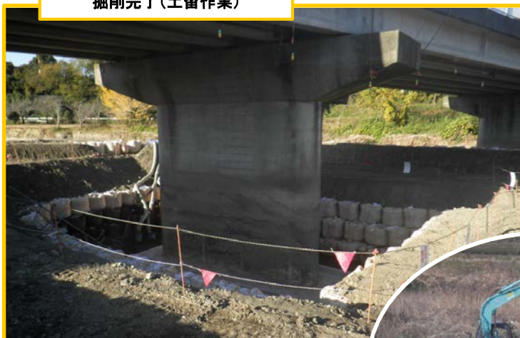
掘削完了（土留作業）
