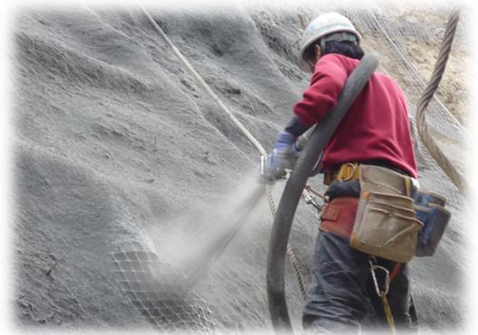
植物の生育に必要な土層の崩壊、降雨等による浸食を抑制するために網を張り付けます。
