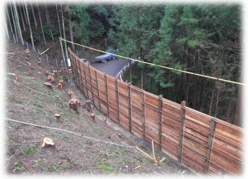
土留め板設置後は、沢山ある切り株の抜根をします。 その後、山の斜面を切り崩していき、なだらかにしていきます。
