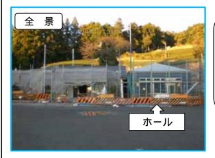
外壁は窯業系サイディングという外壁材を使用しました。 この外壁材はセメント質と繊維質が主な原料で、防火性・ 耐震性・遮音性に優れています。一般住宅でも多く使用 されています。
