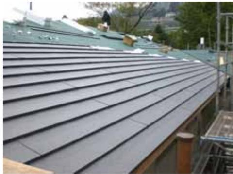
瓦の屋根がガルバニウム鋼板の段葺き屋根に変わりました。ガルバニウム鋼板の屋根はアルミと亜鉛でできているため、瓦の屋根に比べ、随分軽くなっています。
