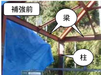
耐震性をアップさせるため、梁を2重にし、新たに方杖・火打ちを溶接しました。
