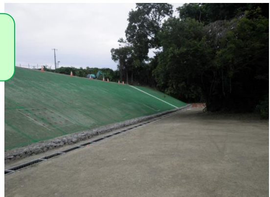
盛土 完成写真
