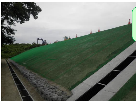
盛土締固め完了
