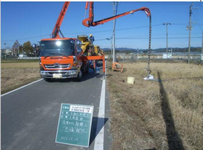
流動化処理土を生コン車で運搬してその後、ポンプ車に移し打設します。昔の用水路はあらかじめ上部に穴を開けておきます。
