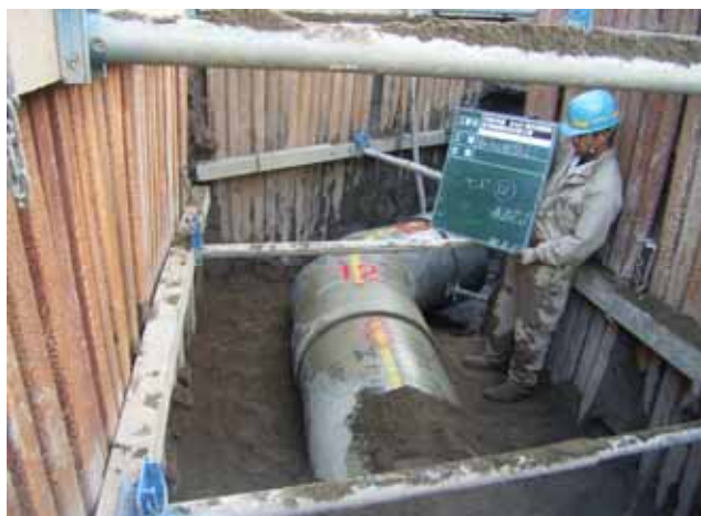
管の埋設作業を行っています。
