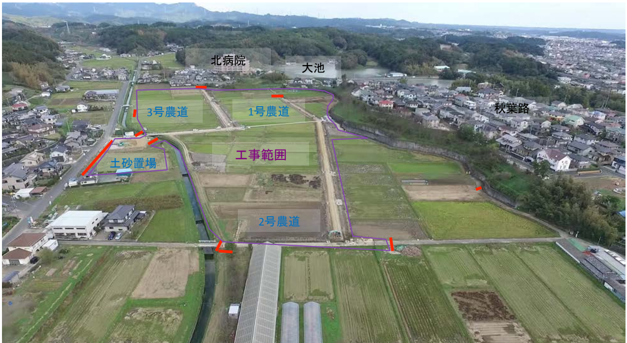
平成30年11月14日現在の様子(弊社所有ドローンにて撮影)
