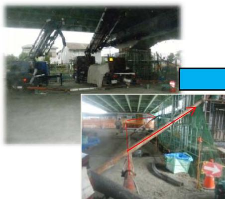
コンクリートはポンプ車を2台セットし生コンの打設ムラがでないように、また、水平な仕上がりとなるように(赤矢印)2箇所から生コンを入れました
