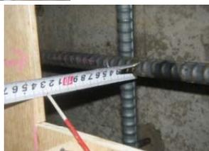
型枠組立完了後、鉄筋と型枠の間隔が設計値どおりになっているか最終確認します。
