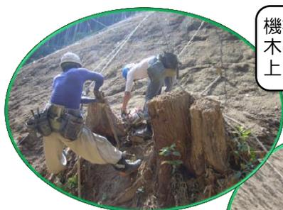
機械にて法面を掘削した後、切株や木の根を人力にて撤去し、法面を仕上げていきます。
