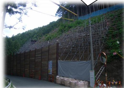
仮設足場を組立しました。法面に167本のロックボルトを挿入するための作業構台になります。
