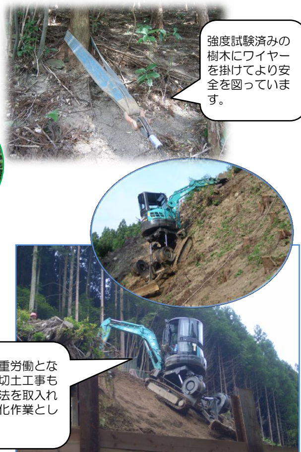
法面バックホウでの作業写真
