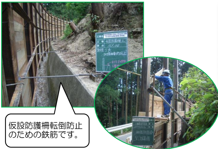
仮設防護柵組立写真
