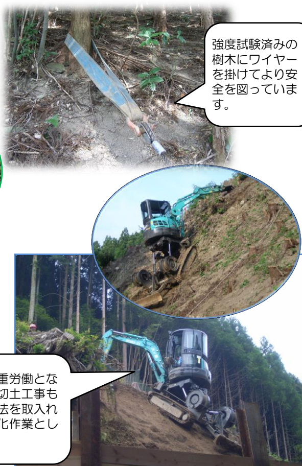
法面バックホウでの作業写真
