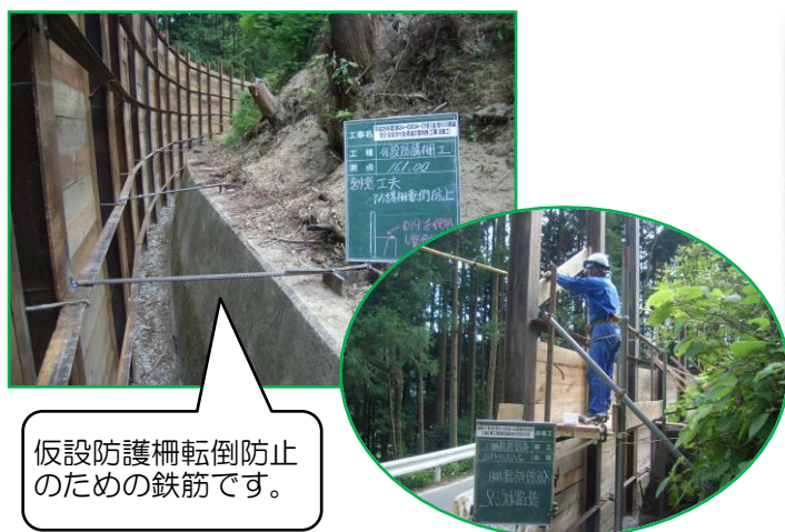
仮設防護柵組立写真
