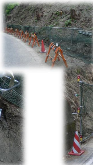
安全防護ネット設置
