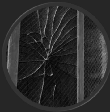
飛散物で窓ガラスが割れる
