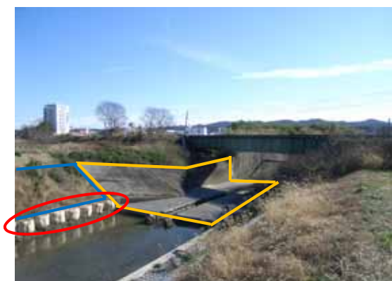
【天浜線上流側】
