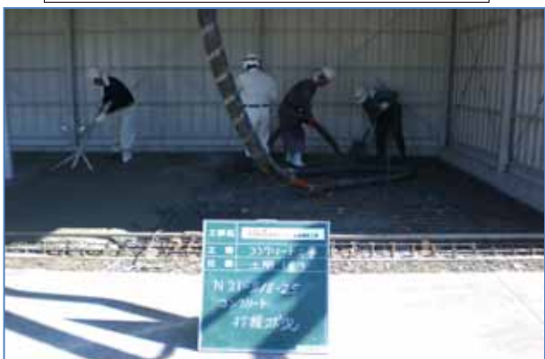
土間コンクリート打設作業
