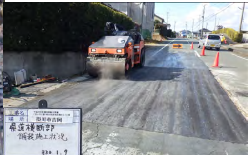
写真 県道横断部の舗装施工
